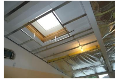
Slika 3: Izolacija stropa
